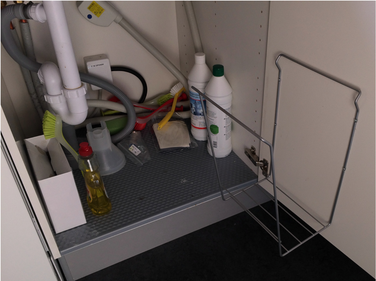
Skrald er fjernet. Om vinteren SKAL LÅGEN efterlades åben, så der ikke kommer frost i rør.
